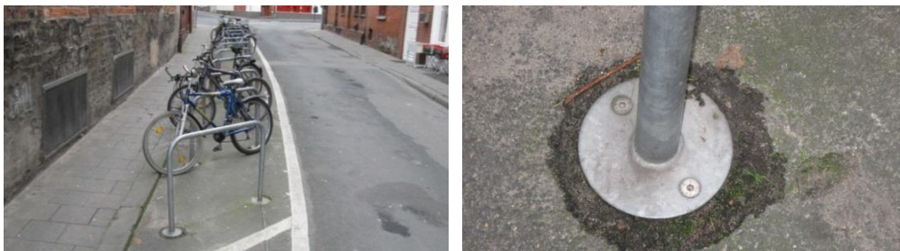
Bild 3-5: Beispiele für verschraubte Rahmenhalter (Lüneburg)
